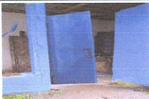
Foto 5: CAMBIO DE PUERTA FINALIZADA
