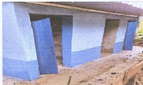
Foto 4: REPARACION Y MANTENIMIENTOS DE SERVICIOS SANITARIOS FINALIZADAS
